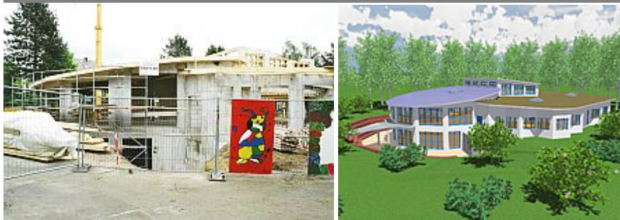
Der Rohbau des Fraktalen Schulgebäudes - und was aus diesem werden wird
